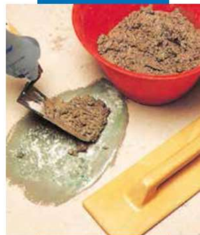
Rappezzo di pavimento: applicazione malta
