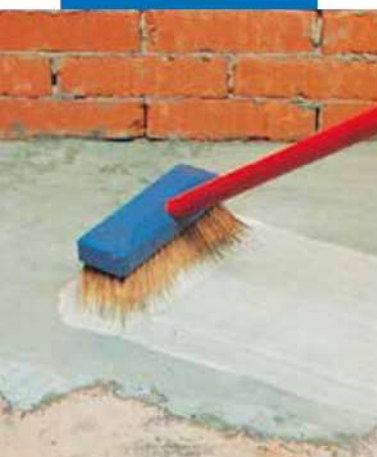
Applicazione di boiacca cementizia additivata con Planicrete
