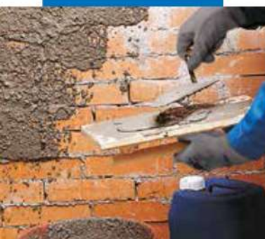
Rinzafo additivato con Planicrete
