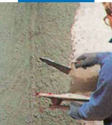
Rinzaffo adesivo additivato con Planicrete
