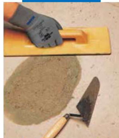
Rappezzo di pavimento: lisciatura finale
