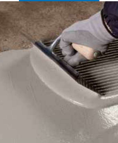
Applicazione della prima mano di Mapelastic Turbo
