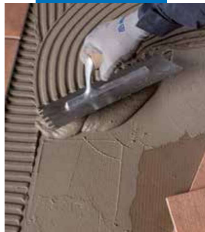
Posa di piastrelle con Elastorapid
