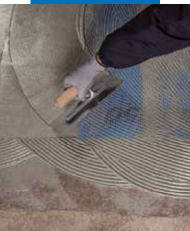
Inserimento di Mapenet 150 nella prima mano di Mapelastic Turbo fresca
