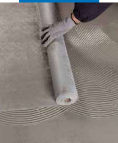
Inserimento di Mapetex Sel nella prima mano di Mapelastic Turbo fresca
