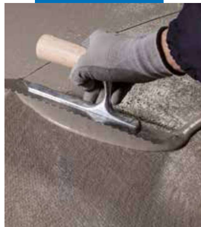
Seconda mano di Mapelastico Turbo su prima armata con Mapetex Sel
