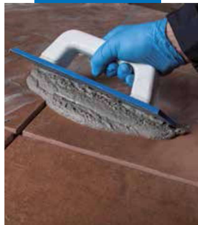
Stuccatura di piastrelle con Ultracolor Plus
