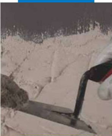
Applicazione di intonaco su Eco Prim Grip
