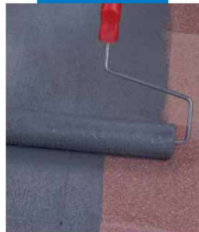
Applicazione di Eco Prim Grip a rullo su vecchio pavimento in marmette
